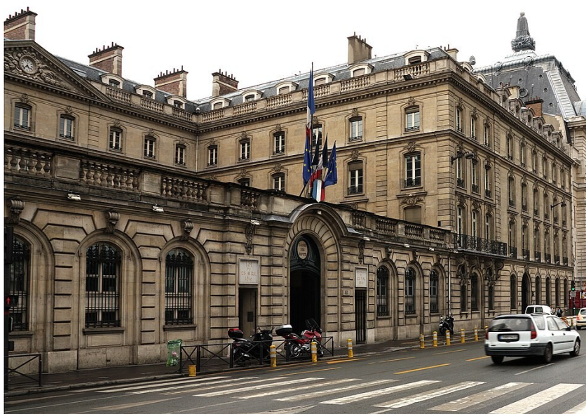
Siège de la Caisse des dépôts et consignations.
